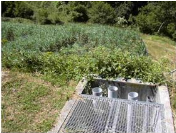
Figure 89 : exemple de regard de répartition
