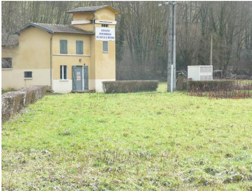
Figure 10 : captages du Martinet
